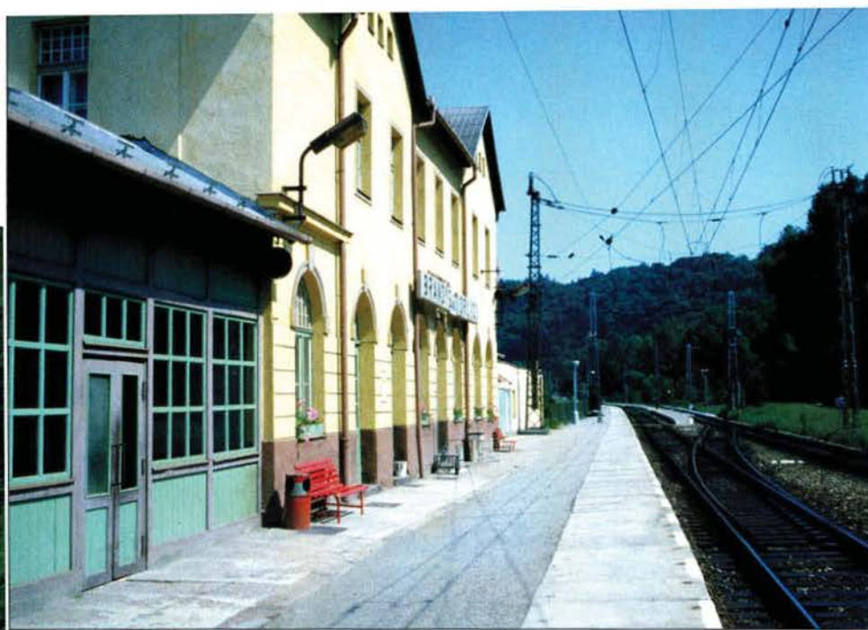
Im Bahnhof Brandys nad Orlicí hängt die Gleichstromfahrleitung trotz diverser Rekonstruktionen an typisch deutschem Quertragwerk.
